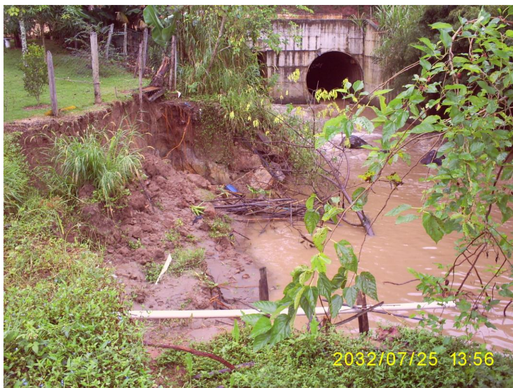
Vista para a galeria de montante
