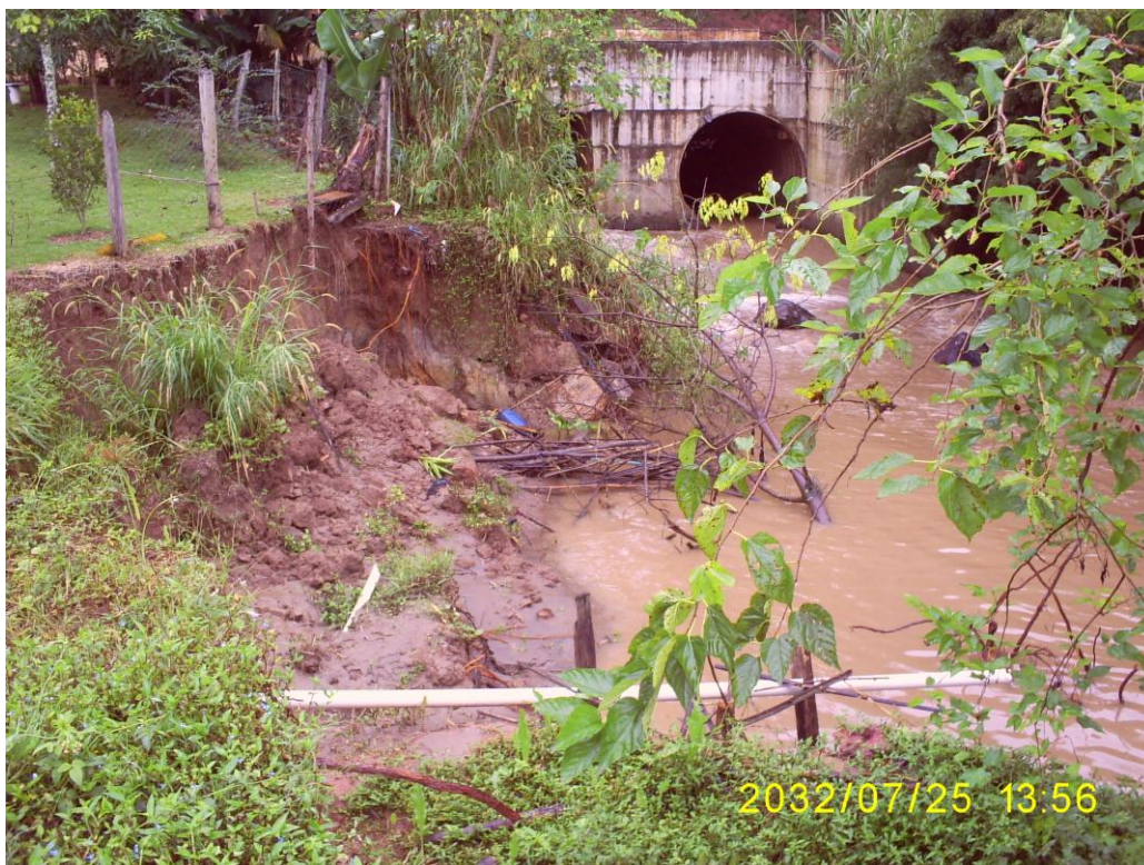
Vista para a galeria de montante
