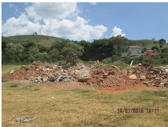
Figura 79 - Fotos da área de depósito
