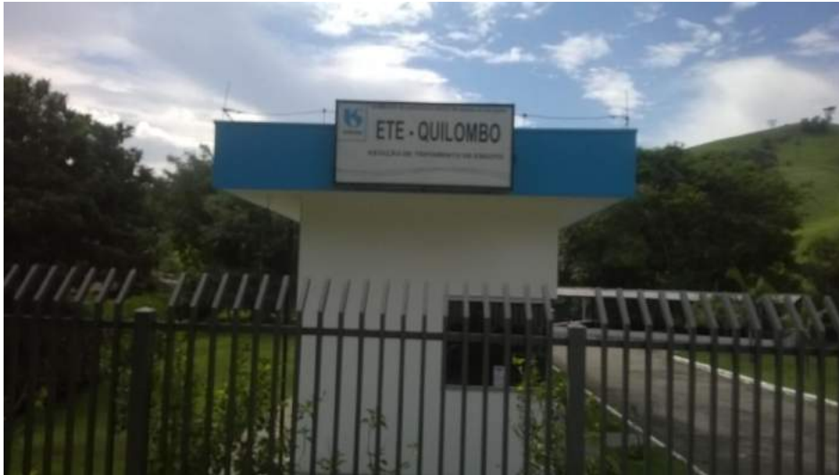
Figura 20 - Entrada da ETE - Quilombo
