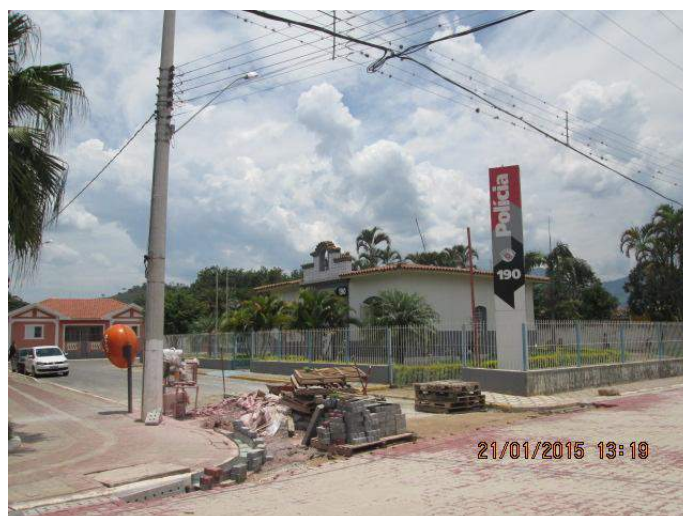
Figura 77 - Geração de RCC a partir de obra de infra-estrutura urbana. Ação realizada pelo Setor de Obras e Serviços Municipais
