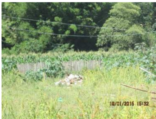
Figura 61 - Resíduos da construção civil acondicionados no terreno do gerador
