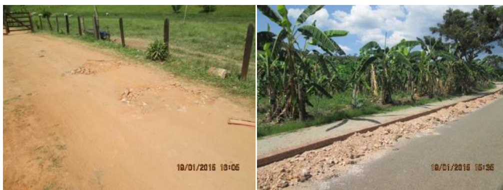
Figura 63 - Reaproveitamento de materiais inertes em estradas rurais
