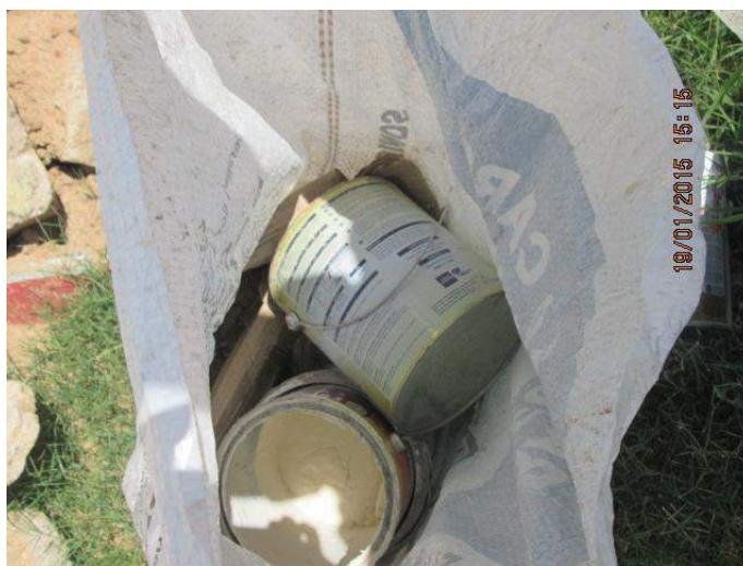
Figura 82 – Resíduos perigosos encontrados na área de depósito de resíduos da construção civil
