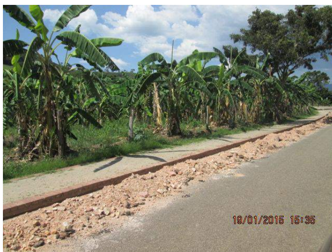
Figura 76 - RCC utilizado para a manutenção de estrada urbana. Ação realizada pelo Setor de Obras e Serviços Municipais
